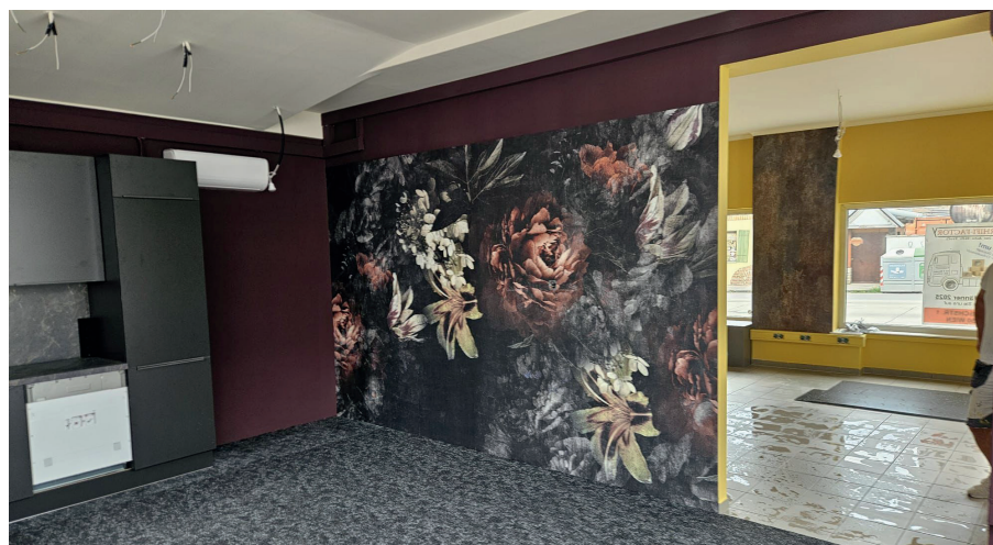
Die Umbauphase – mehrere Gewerke müssen effizient zusammenarbeiten.
